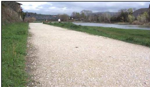
infatti, fino ad oggi, sono le più utilizzate per le piste ciclabili in ambiente extra-urbano. Si realizzano preparando il cassonetto di fondazione su cui si stende uno strato di stabilizzato di cava di pezzatura 0/30 mm. che verrà rullato e compattato al fine di rendere la superficie il più liscia possibile. Questa tecnica presenta un lavoro finito
