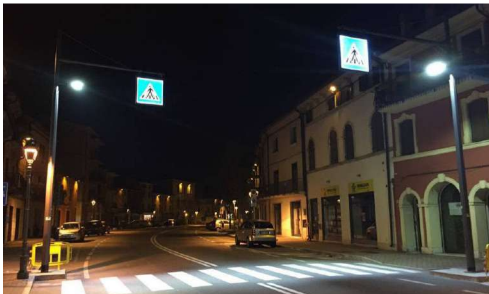
Attraversamento pedonale in modalità notturna
