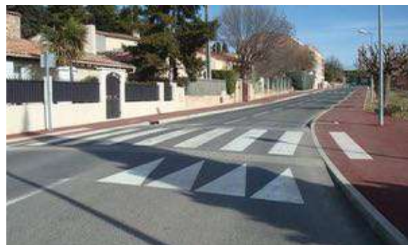
Attraversamento con "isola salvagente" e attraversamento rialzato
