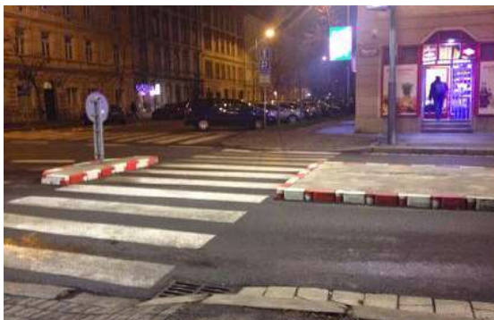
Attraversamento con "isola salvagente" e attraversamento rialzato
