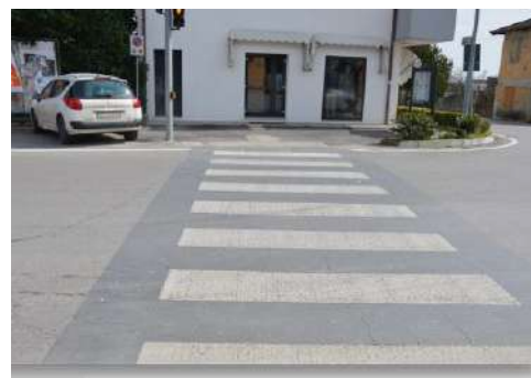
Vernice con microsfere rifrangenti e semaforizzazione
