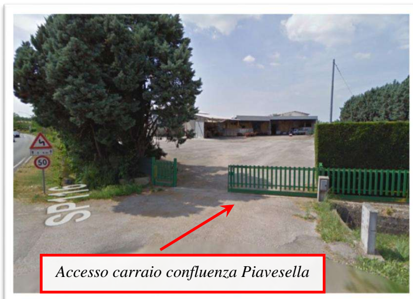
Accesso carroia lungo la S.P. 116 prima della confluenza nel Piavesella (SB7)
